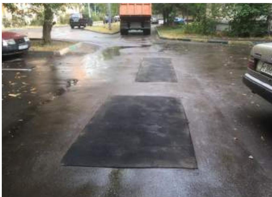
По состоянию на текущее время в зимний период отремонтировано 1100,84 м<sup>2</sup> с применением литой асфальтобетонной смеси.
