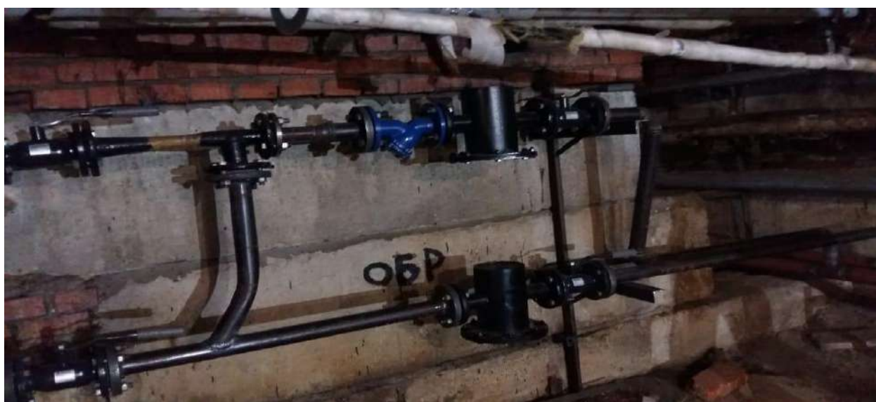
Завершенный монтаж элеваторного узла Василисы Кожиной д. 8 к 3
