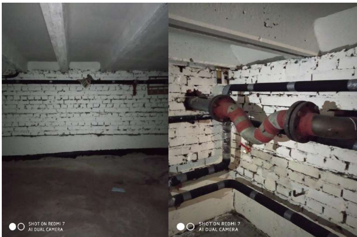
Василисы Кожиной д. 8 к 3 завершенные системы водостока и подвала
